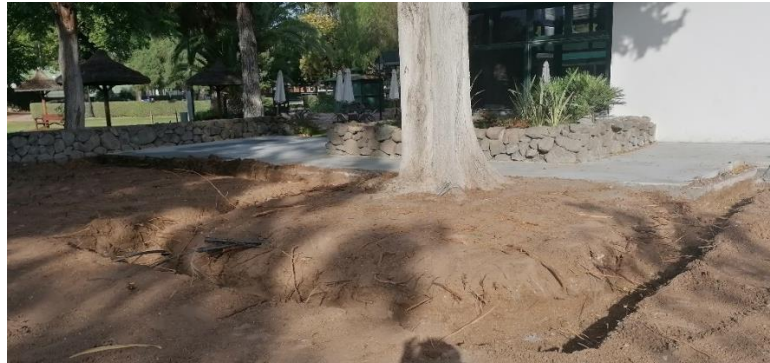
Control de afección de raíces durante las obras en Casa Club
