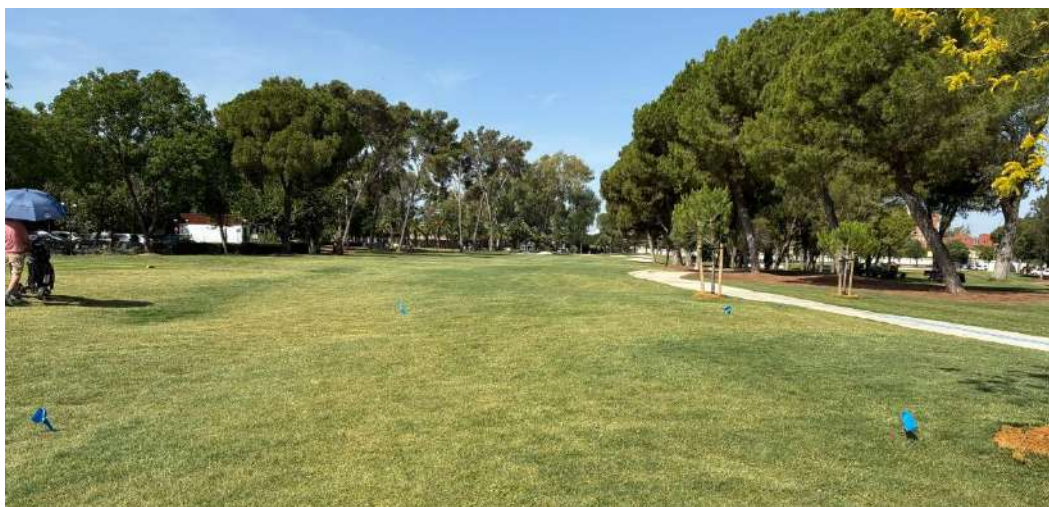
Foto 2. Replanteo de las cuatro esquinas del nuevo tee del 14
