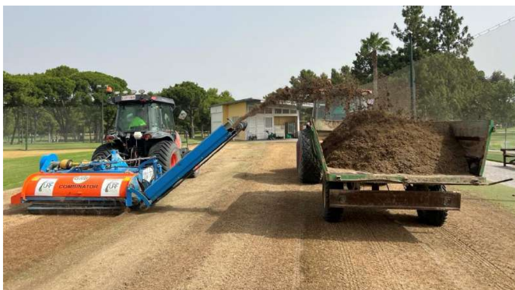
Foto 5. Máquina Koro que se encarga de realizar el decapado del AG del chiping green. Con esta misma máquina se realizará el decapado de los collares de bermuda de la primera vuelta.
